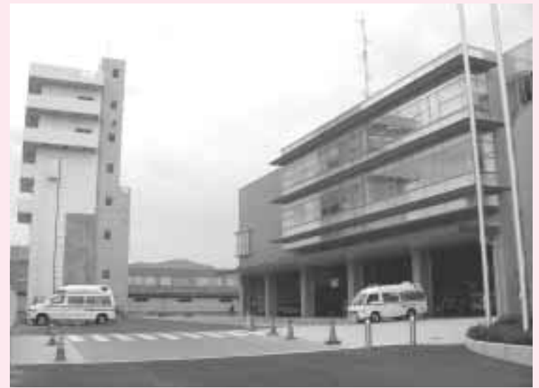
粕屋南部消防署 新庁舎
