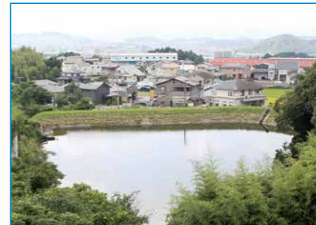
漏水がみられるため池
