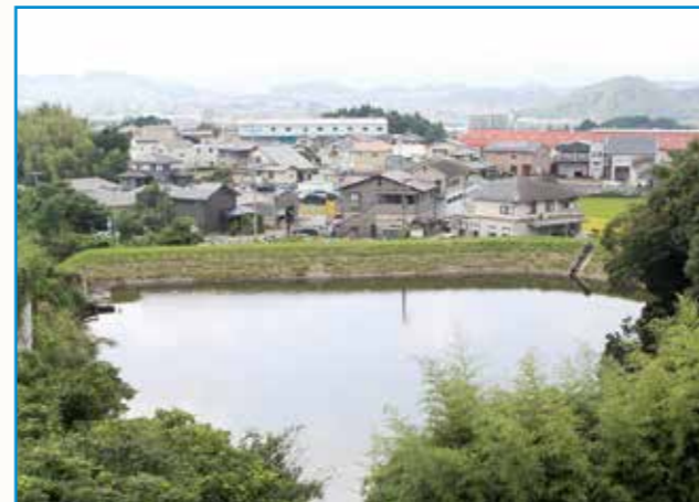
漏水がみられるため池
