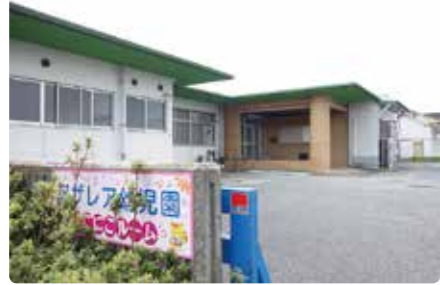
旧アザレア幼稚園にこころルームを改修
