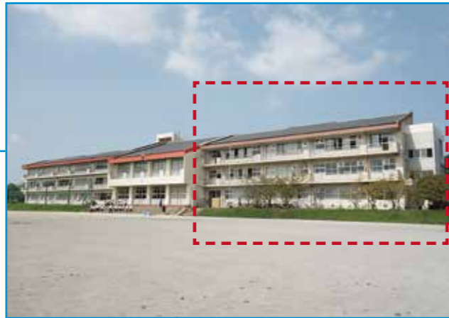
第二期工事部分
