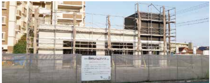
建設中のオープンイノベーションセンター（平成29年9月完成予定）
