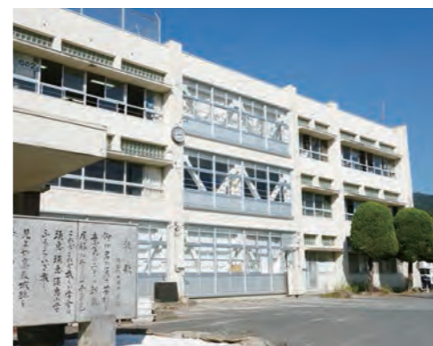
第一小学校校舎耐震補強工事
