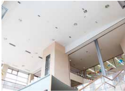
改修工事が行われるオイコスの照明
