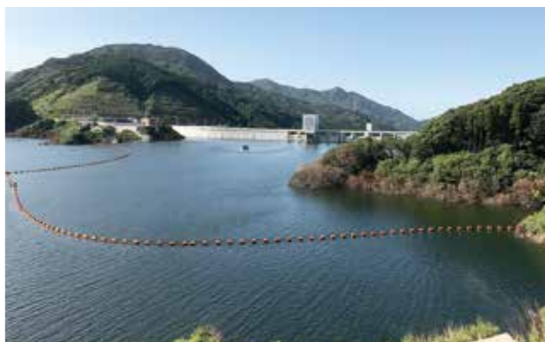
試験湛水中の五ヶ山ダム
