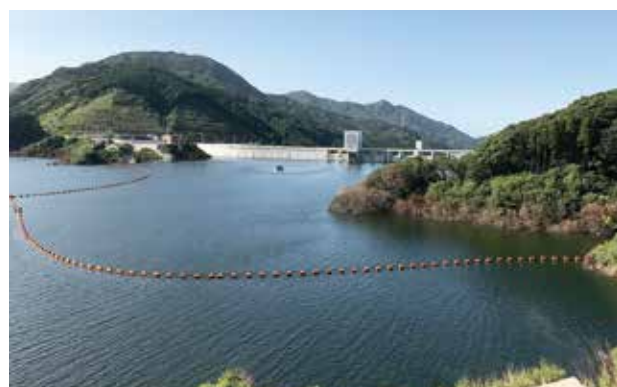
試験湛水中の五ヶ山ダム
