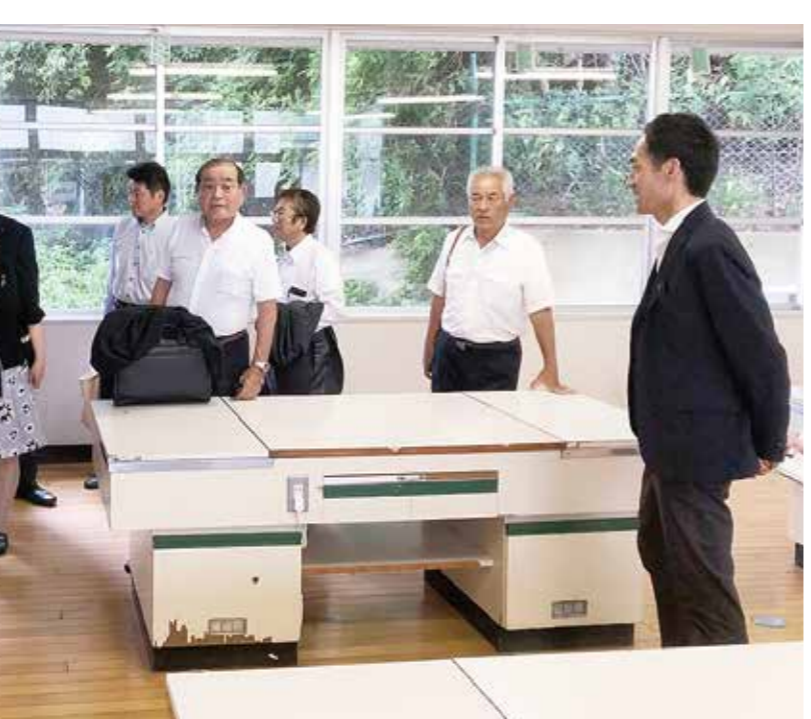
学童に利用するには危険な調理室
