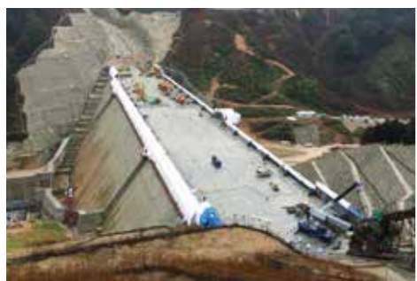
工事が進む五ヶ山ダム(那珂川町)
