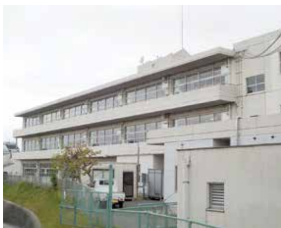
今回工事が行われる普通教室棟
