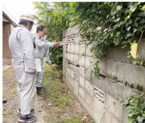
倒壊のおそれがあるブロック塀
