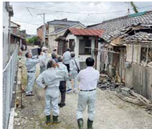
屋根が崩落した家屋
