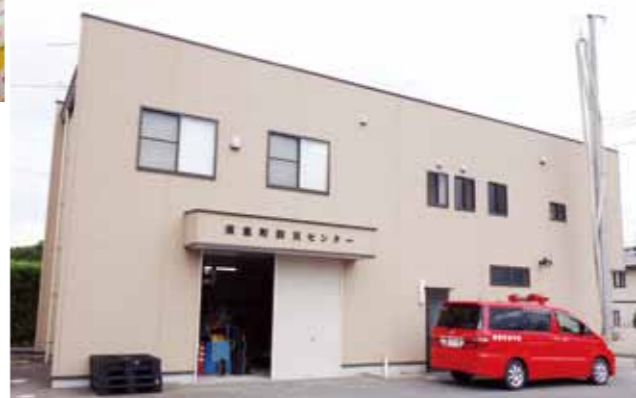
中央防災センター（役場敷地内）
