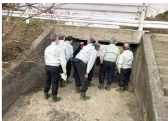
修繕状況の確認
