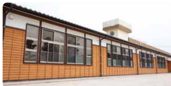
4教室が増築された二小校舎
