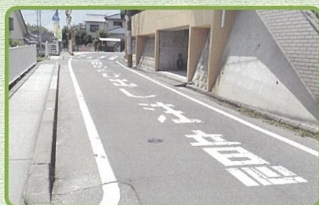
昨年度要望した改善箇所 (路面標示)
