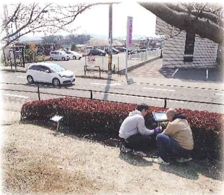
ライトの設置作業
